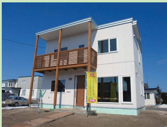
カラマツ無垢材を構造材に活用した木造住宅（斜里町）
